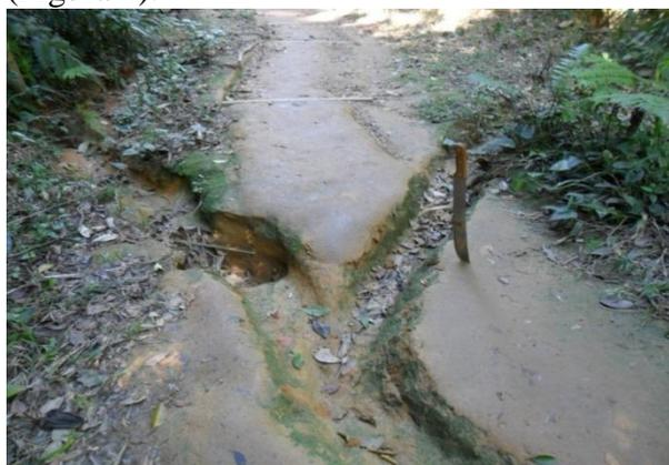
**Figura 4.** Formação de ravina no leito da trilha evidenciado concentração do escoamento de água e ao fundo contenções de madeira formando degraus próximos ao primeiro ponto de coleta. Acervo: L. A. Rangel, 2012.
