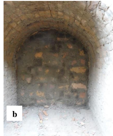
Figura 4. a) Área de estocagem dos cacos e b) Argamassas de vedação de fornos com utilização de cinzas
