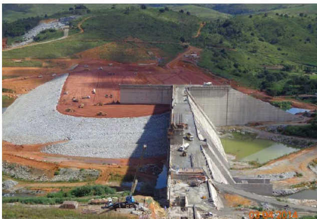
Figura 7. Aspectos da construção da barragem de Serro Azul em abril de 2014.
