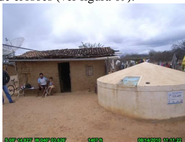
Figura 04 – Cisterna de placa.
