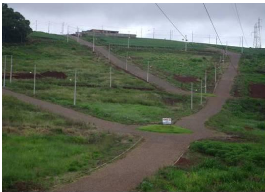
Figura 04 – Foto com vista parcial loteamento Cidade Campo III.
