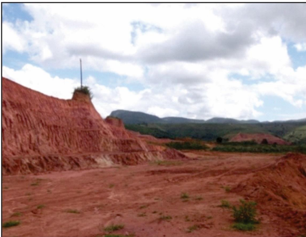
Figura 12. Barragem Serro Azul. Margem direita, apresentando retirada do material argiloso.
