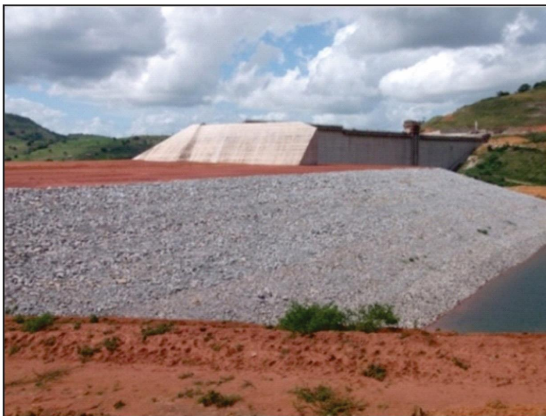
Figura 14. Visão da ombreira esquerda Barragem Serro Azul, realizada com material de argila e presença de enrocamento.
