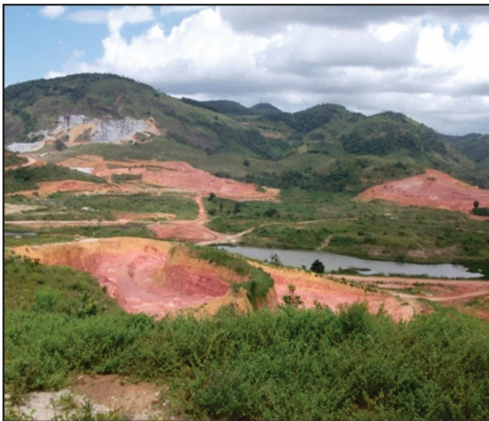
Figura 13. Visão geral do empreendimento apresentando ambas as margens (Julho, 2014).
