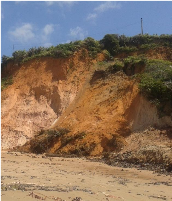
Figura 13. Escorregamento translacional. Fonte: Fotografia dos autores, 2016.
