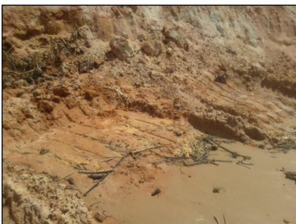
Figura 18. Fotografia mostrando marcas da escavadeira de trator, indicando retirada de material argiloso da falésia. Fonte: Fotografia dos autores, 2016.
