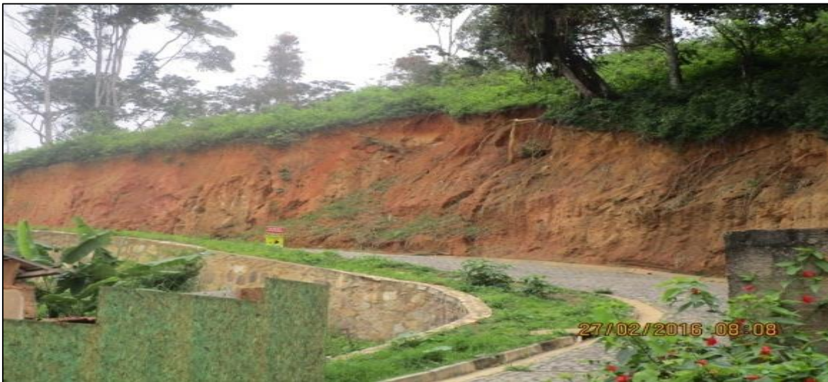
Figura 4. Estrada que foi abeto para construções de grandes imóveis na área de encosta. Fonte: Autores (2016).
