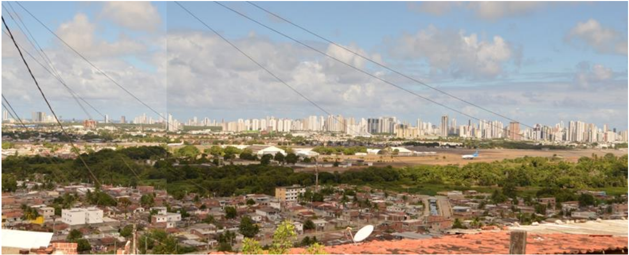
Figura 2. Mosaico de fotografias mostrando a pista do aeroporto Recife/ Guararapes – Gilberto Freyre, situada em uma área plana. Fonte: Autores 2017.
