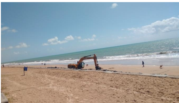
Figura 12 – Obra de entroncamento de sedimentos que acontece no início do setor 2, na praia de Boa Viagem, Recife/PE. Fonte: Souza, 2017.
