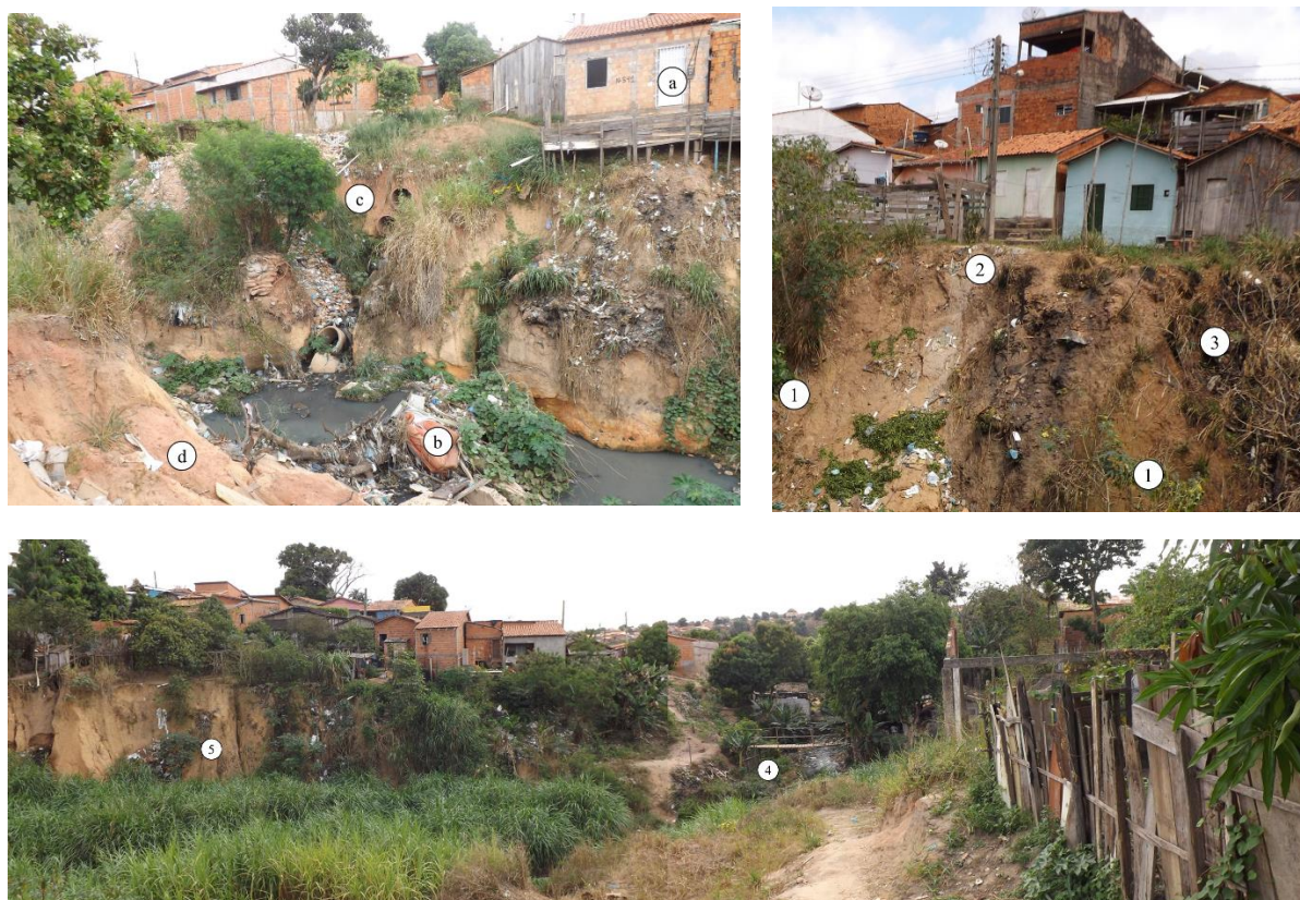
Figura 9: Ocorrências observadas em V2 . (a) Residência em risco; (b) lixo doméstico; (c) canalização do esgoto; (d) sinais de rastejo. (1) Movimento de massa; (2) fendas e solapamento de base; (3) sistema radicular exposto; (4) canal fluvial; (5) ravinas e erosão laminar.
