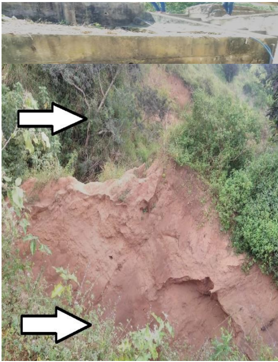
Figura 10. Voçorocas na parte superior da cabeceira. (A) Formação de ravinas no montante sem cobertura e com produção de sedimentos no sopé da encosta. (B) Voçoroca estável com cobertura vegetal na borda central da cabeceira de drenagem.
