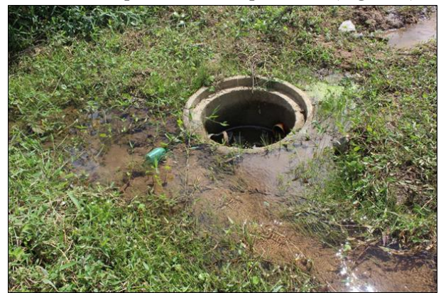
Figura 4. Abertura realizada pela Prefeitura da cidade para lançamento de água que nasce na cabeceira e é servida nas redondezas. Não se tem tratamento primário para o uso da água.
