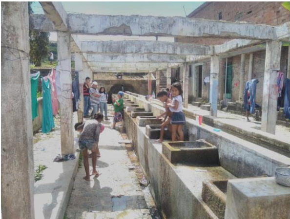
Figura 3. Lavanderia construída pela prefeitura e é utilizada pelos moradores da área. Todos os usuários tem acesso 24h. Após o uso, a água e os materiais utilizados são lançados no canal que tem como destino final o rio Mundaú.
