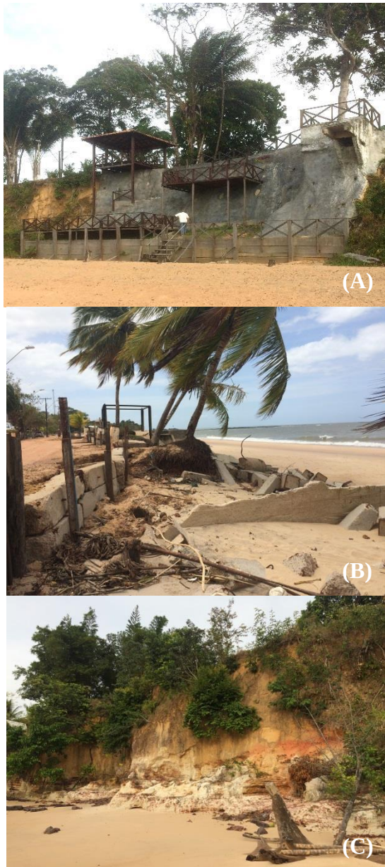
Figura 2. Ocupação sobre falésias no setor oeste, com revestimento por concreto e construções de casas (A). Setor leste: sem falésias, mas com construções sobre o pós-praia (B) e, com falésias sem construções na sua extremidade (C).
