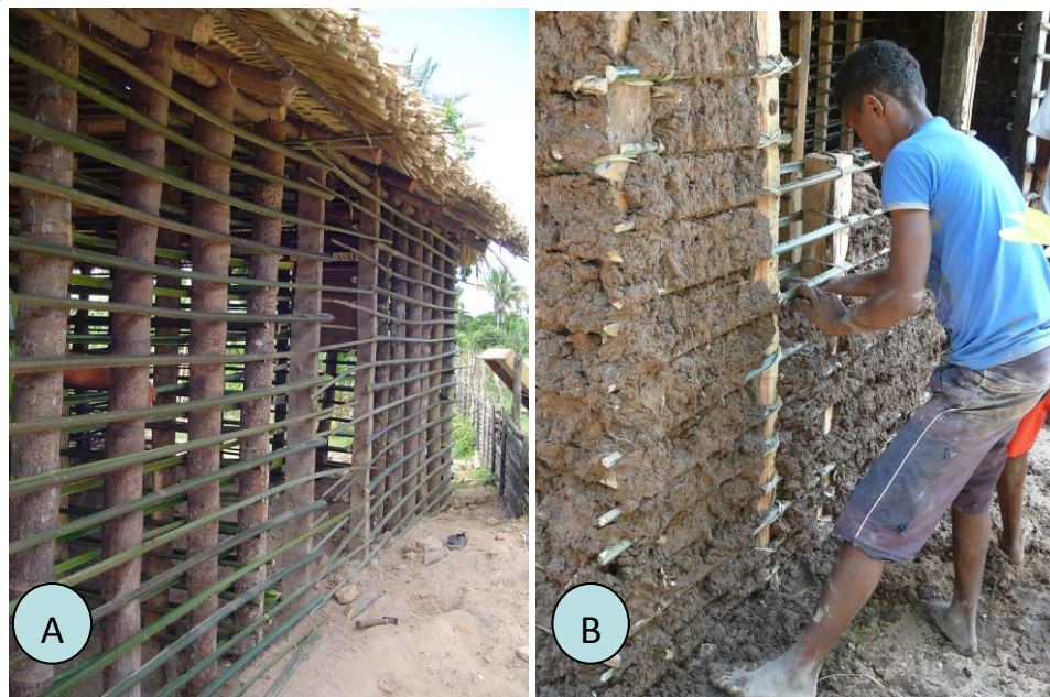
Figura 10. A) Armação das Paredes com Talos (Raques) de Folhas de Babaçu; B) Preenchimento da Armação das Paredes com Barro.
