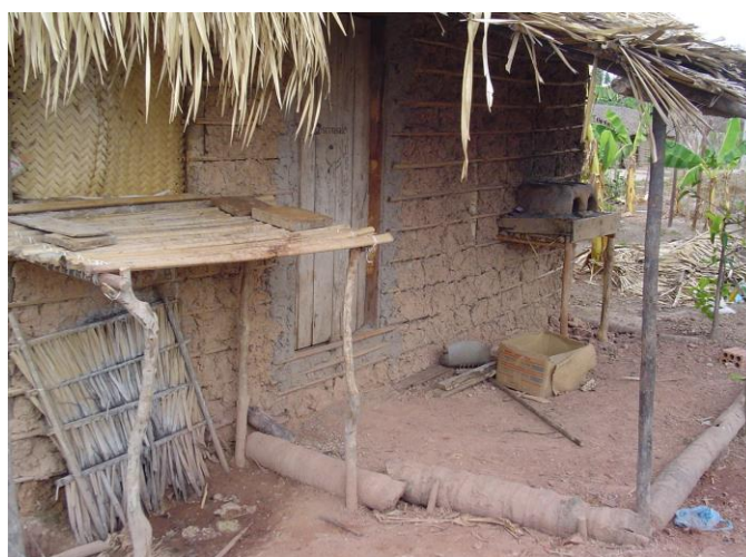
Figura 11. Extensão da Casa – Varanda de Fundo e Jirau de Lavagem de Panelas
