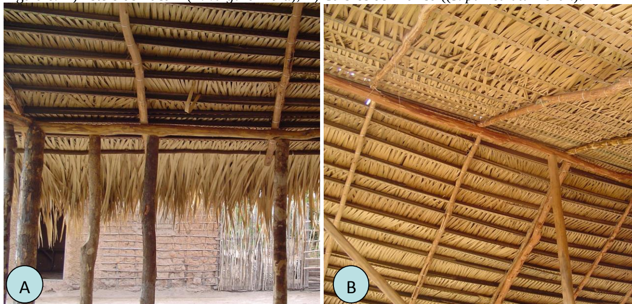
Figura 7. Grade (A) e Cumeeira (B) em Construção na Região de Estudo.
