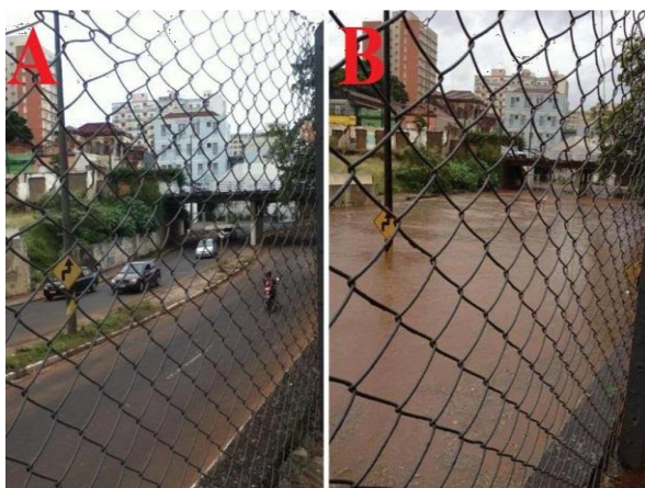
Figura 13. A: trecho da via expressa em Fevereiro de 2013, sem a ocorrência de chuvas e enchentes, B: mesmo trecho da Via Expressa e no mesmo mês e ano, durante enchente. Fonte: adaptado de foto de Danilo Soares e acervo do Portal Araraquara, administrado pelo primeiro autor.
