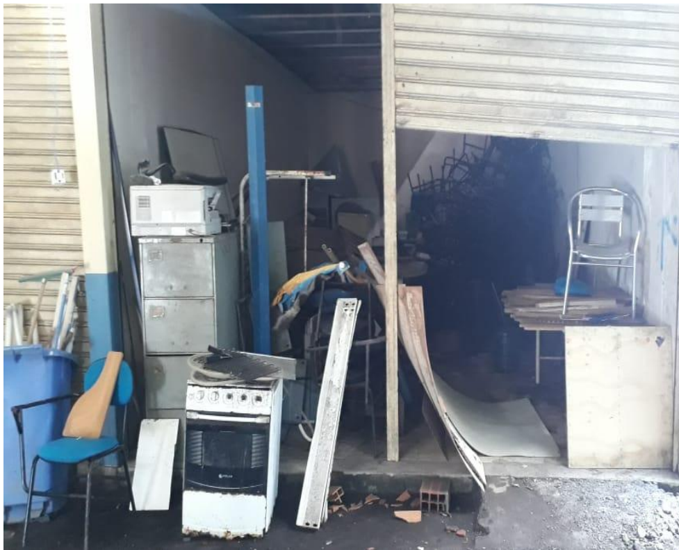
Figura 6. Resíduos armazenados incorretamente ao lado do Lab. de Design. Fonte: Autores, 2019.
