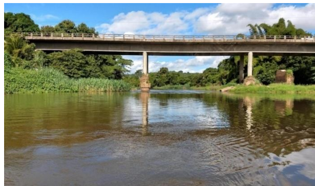
P8 - Abaixo da ponte da BA 290, esta após a cidade de Teixeira de Freitas, próxima a estação fluviométrica (55490000).
