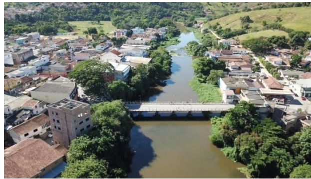
P2 - Dentro da cidade de Medeiros Neto e próximo à estação fluviométrica (55460000), possui lançamentos de efluentes sem tratamento.
