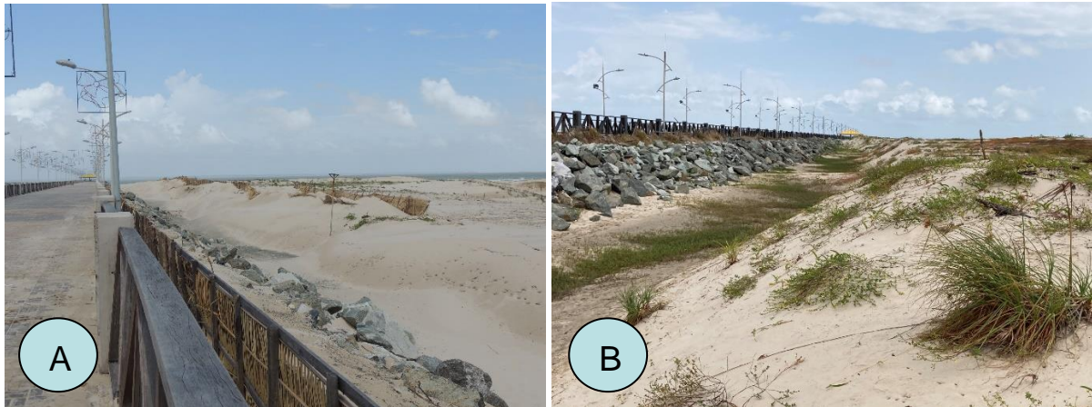
Figura 6. Aspecto de canal formado entre a estrutura de enrocamento do espigão com dunas laterais formadas pela retenção de areia por paliçadas: A) Paliçadas laterais; B) Dunas laterais formadas.
