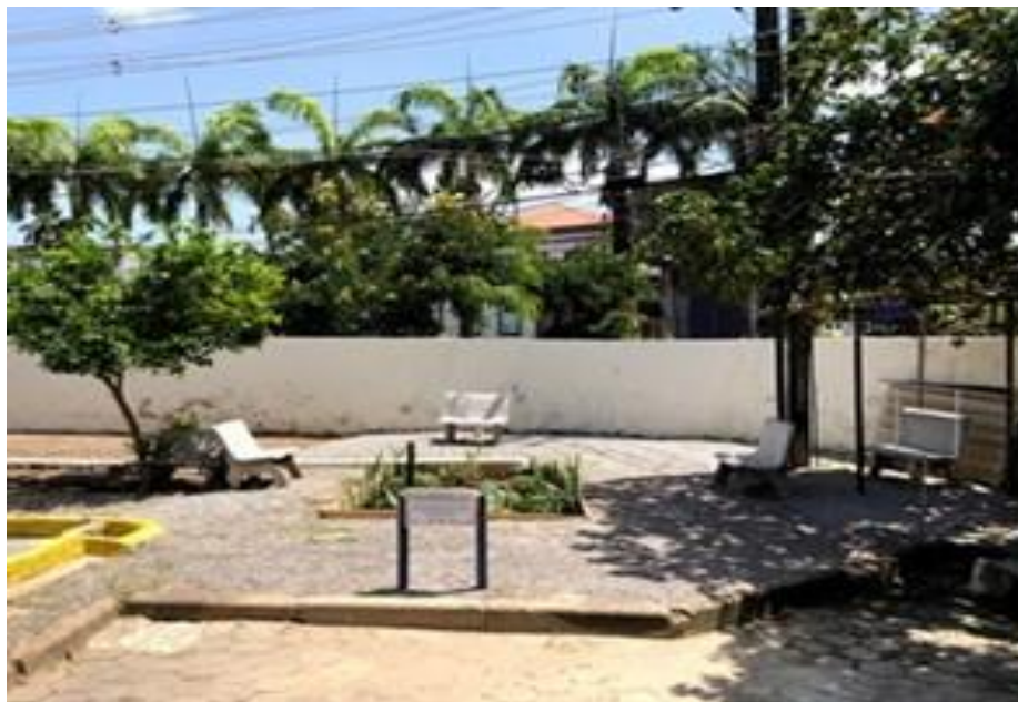
Figura 12 - Jardim de chuva experimental concluído.
