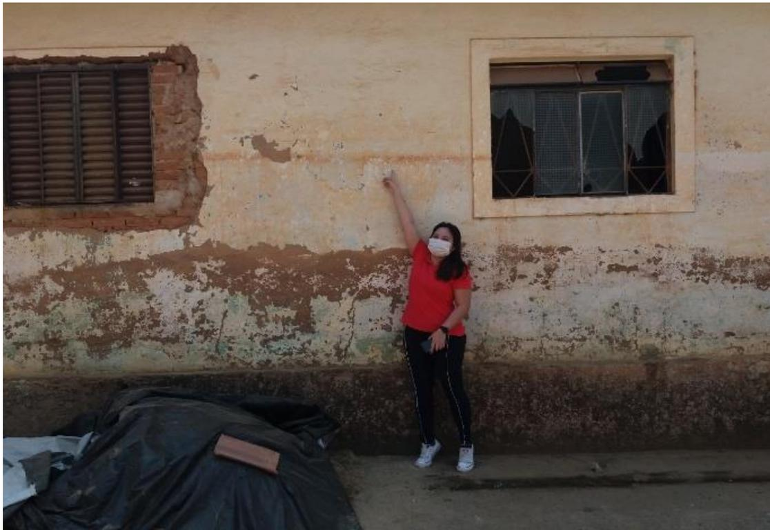
Figura 4. Marca do nível de água que atingiu na inundação de 2000.
