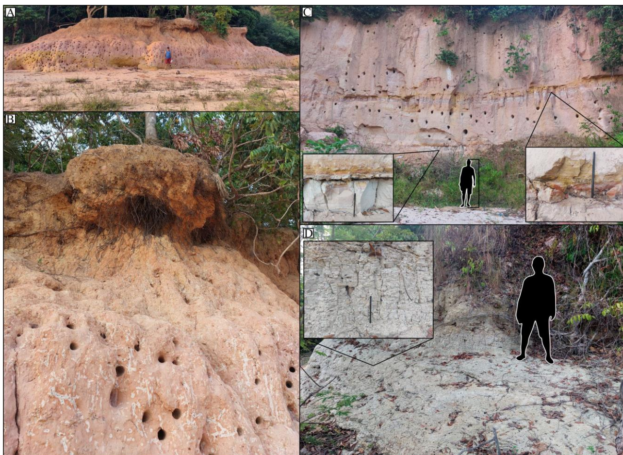
Figura 6. Praia da Juliana, margem direita do lago de Tefé. A) Vertente, localmente denominado “barranco”, com evidentes feições de erosão, conforme detalhado em B, onde observa-se também o horizonte de argissolo; C) Vista da vertente na qual são observadas sucessões de rochas sedimentares; e D) Nível mais inferior da vertente, com a ocorrência de pelitos friáveis acinzentados. Fonte: Confeção própria da autora, 2023.
