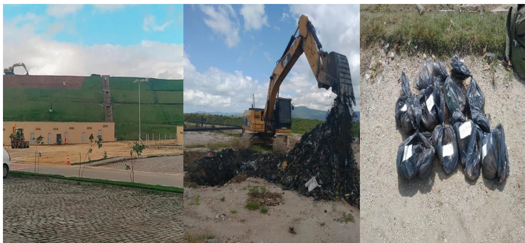
Figura 3 – Escavação, retirada e acondicionamento de resíduos no ASMOC.
