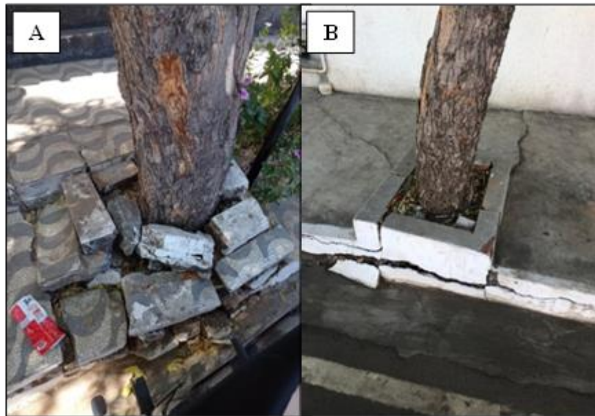
Figura 8. Destruição do passeio público causado pelo sistema radicular da espécie Azadirachta indica , nas duas imagens acima (A e B) presente na arborização urbana de São Francisco do Maranhão.
