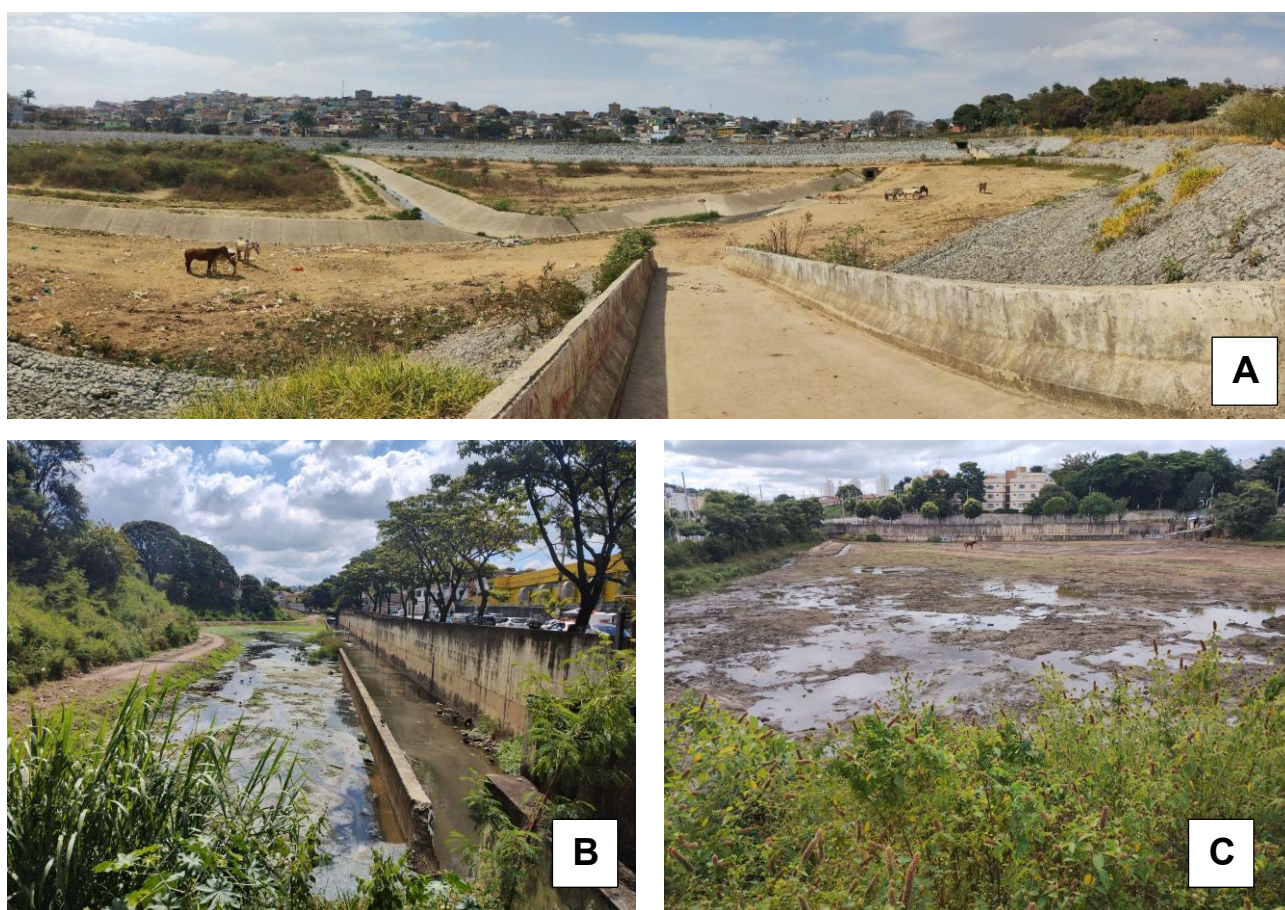
Figura 9 – A: Bacia de retenção Túnel/Camarões em agosto de 2024, notar a presença de animais pastando no interior da bacia. B: bacia de retenção Liége em abril de 2024, notar vegetação ruderal em crescimento e retenção de água o que favorece a proliferação de animais vetores de doenças. C: bacia de retenção Várzea da Palma em abril de 2024, notar a presença de animais pastando, vegetação em crescimento, retenção de água e ocupação irregular. Fonte: registros de campo obtidas pelos autores, 2024.
