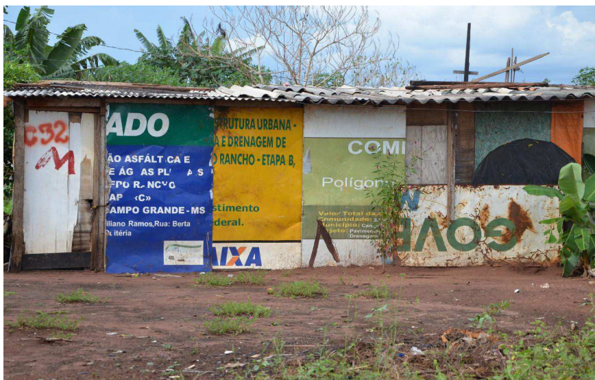
Imagem 2 – Barracos construídos com o que, ironicamente, sobrou da publicidade do Estado: promessas demais.
