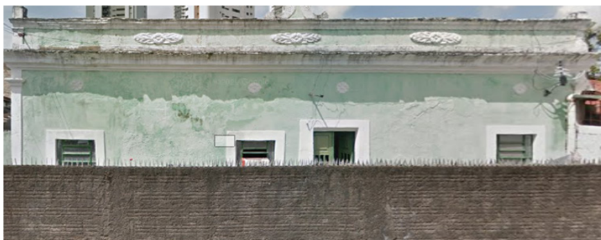
Figura 2: Interface de edificação remanescente com a Ponte Eng Jaime Gusmão. Fonte: ( https://www.google.com/streetview/ - Acesso em 05/10/2024).
