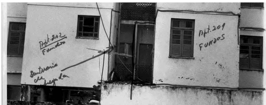
Figura 1: Foto da traseira do Edf. Terezinha, andar dos apartamentos 201 e 202
