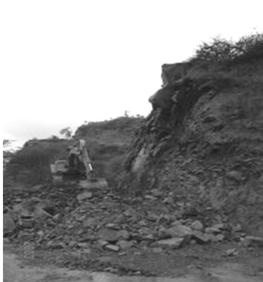
Figura 3. Desmonte para a ampliação da estrada.
