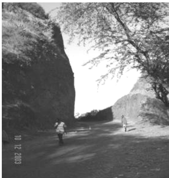
Figura 2. Aspecto de uma curva antes da obra.
