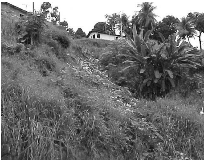
Figura 5. O lançamento do lixo em áreas de encostas constitui-se em fator desencadeador de processos erosivos ou movimentos de massa devido à gênese de cursos preferenciais para a água ou mesmo ao acúmulo da mesma ao longo da encosta. Rua Rio Tigre – Córrego da Areia, Zona Norte da cidade do Recife (Foto da Comissão de Defesa Civil do Recife – CODECIR – 06/2002).
