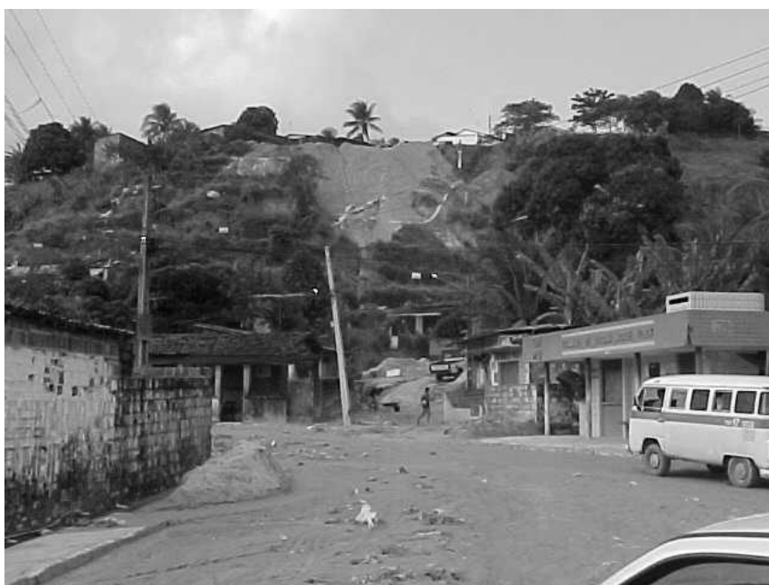
Figura 1. Resultado da concentração de águas da chuva e servidas na encosta localizada na Rua Camanducaia, UR-02 – bairro do Ibura, sudoeste do Recife. Abaixo, a deposição de material arenoso sobre a superfície da rua (Foto da Comissão de Defesa Civil do Recife – CODECIR – 074/2002).
