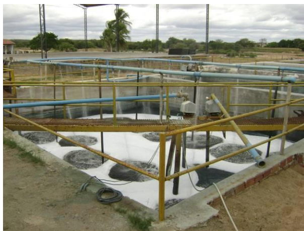
Figura 4. Estação de tratamento de efluentes da Monkey Têxtil S.A. (novembro de 2008).
