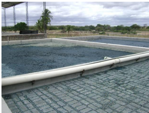
Figura 5. Resíduos químicos provenientes dos efluentes da Monkey Têxtil S.A. (fevereiro de 2009).
