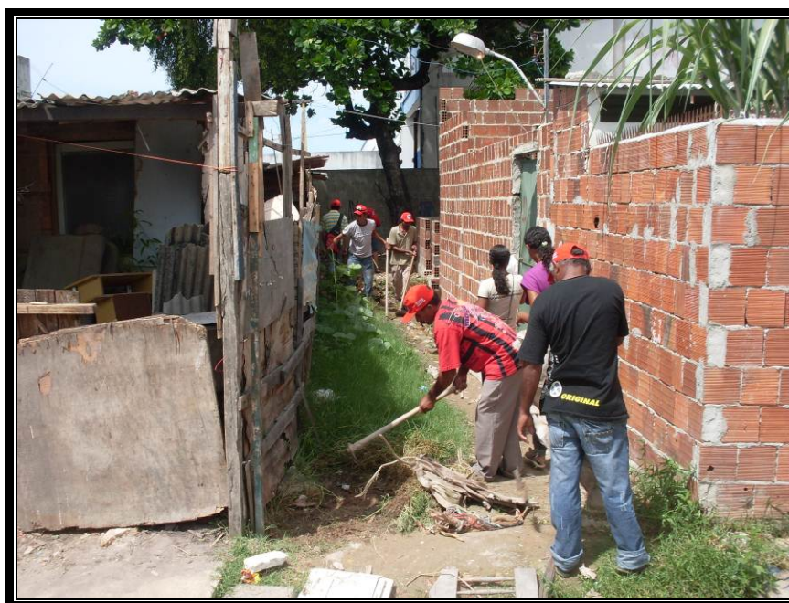
Foto 09 – Comunidade Josué de Castro - Mobilização de membros do MST II (Fonte: foto tomada pelo autor deste artigo, em 21 de abril de 2010). Nota: trabalho de limpeza do terreno.
