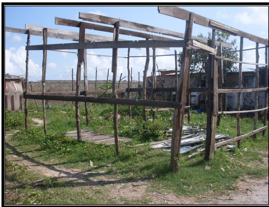
Foto 1 – Comunidade Josué de Castro - Uma ocupação em andamento I. (Fonte: Foto tomada pelo autor deste texto, em 20 de setembro de 2008)
