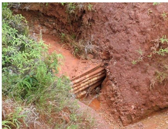
Figura 6. Demonstração do material fino retido nas barreiras de bambú implantadas na área de estudo da Faz. Glória em Uberlândia-MG. Autor: Silva, 2010.
