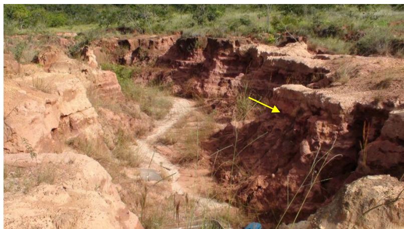
Figura 3. Voçoroca em estudo, com característica das paredes propensas ao desmoronamento na Fazenda Glória de Uberlândia-MG. Autor: Silva, 2008.
