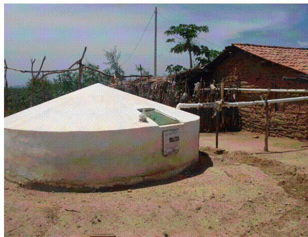
Figura 05 – Cisterna de telhado, para captação da água da chuva (2008)
