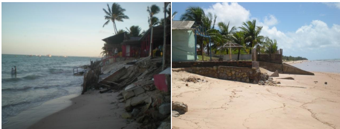
Figura 4 e 5: Erosão costeira e avanço das residências na faixa marítima do município de Cabedelo. Fonte: Marianna M. Neves (2010)
