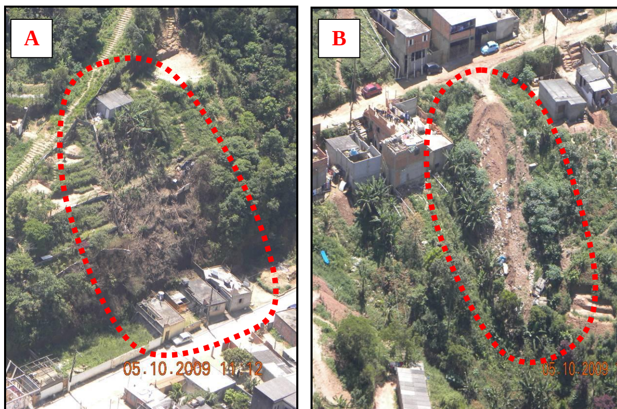
Fig. 3: Visão oblíqua parcial dos setores 8(A) e 5(B) com destaque a cicatrizes de escorregamentos rasos (vermelho), com material mobilizado atingindo moradias.
