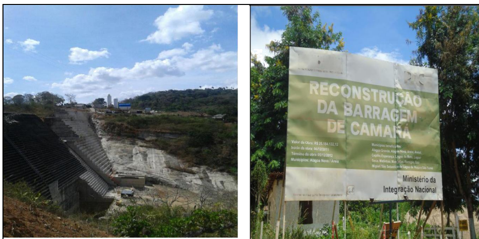
Figuras 04 e 05: Barragem sendo reconstruída e placa sobre a reconstrução da Barragem Camará (Fev./2016). Fonte: Arquivo dos autores.
