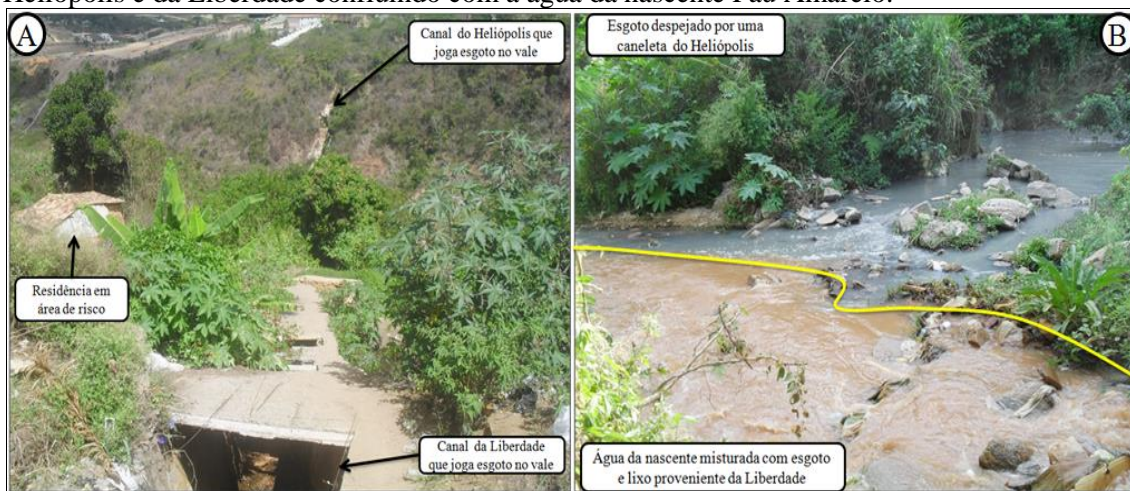
Figura 05- A- Canais de águas pluviais do Heliópolis e da Liberdade B- Esgoto proveniente dos canais do Heliópolis e da Liberdade confluindo com a água da nascente Pau Amarelo.
