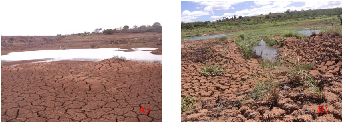
Figura 16- A) Bancos de terra nas proximidades da parede do açude e B) Assoreamento na parte central do reservatório.
