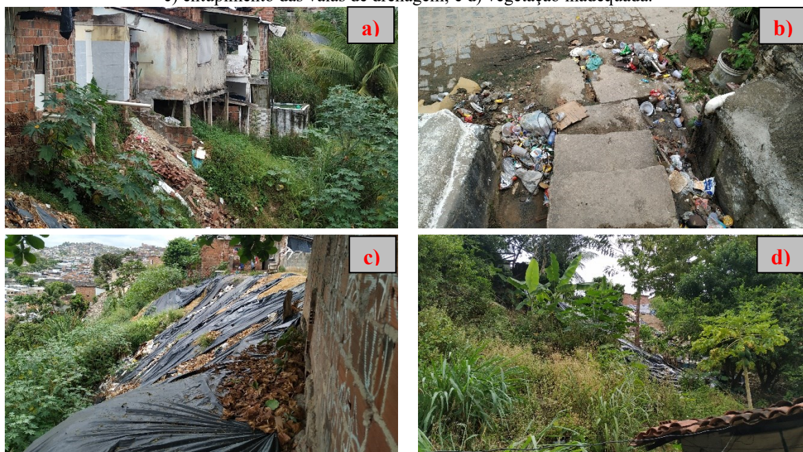
Figura 03 – a) construções irregulares; b) disposição de resíduos sólidos; c) entupimento das valas de drenagem; e d) vegetação inadequada.
