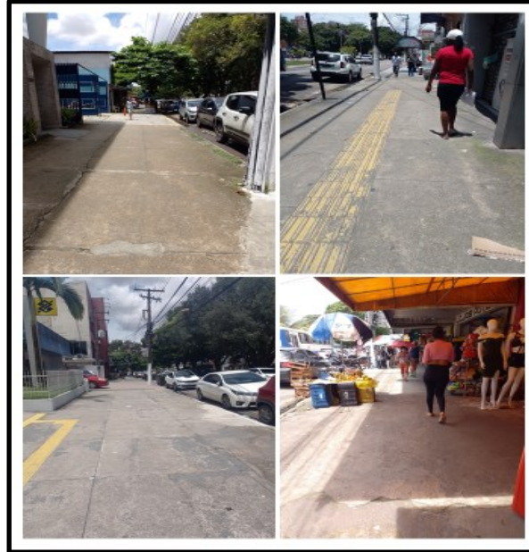
Figura 13 – Bairro da Pedreira – Situação das calçadas na Av. Pedro Miranda – 2022
