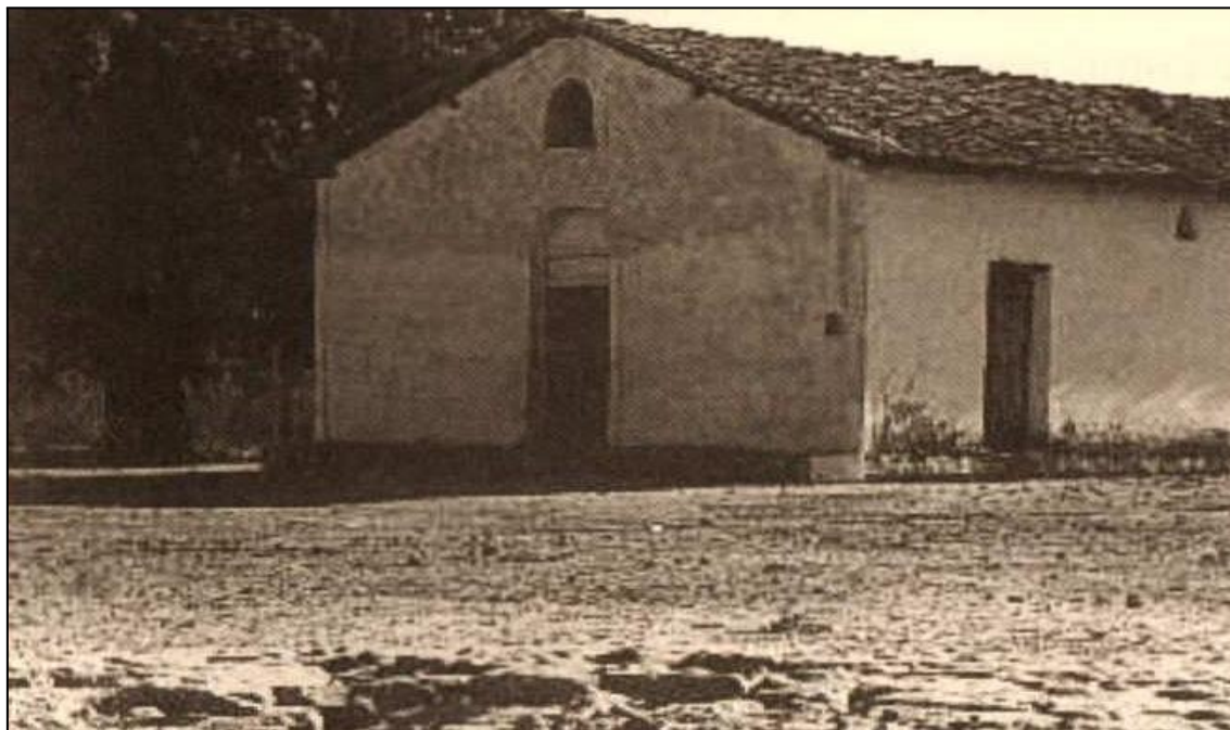
Foto 2 – Igreja nova de Bom Sucesso - 1960
