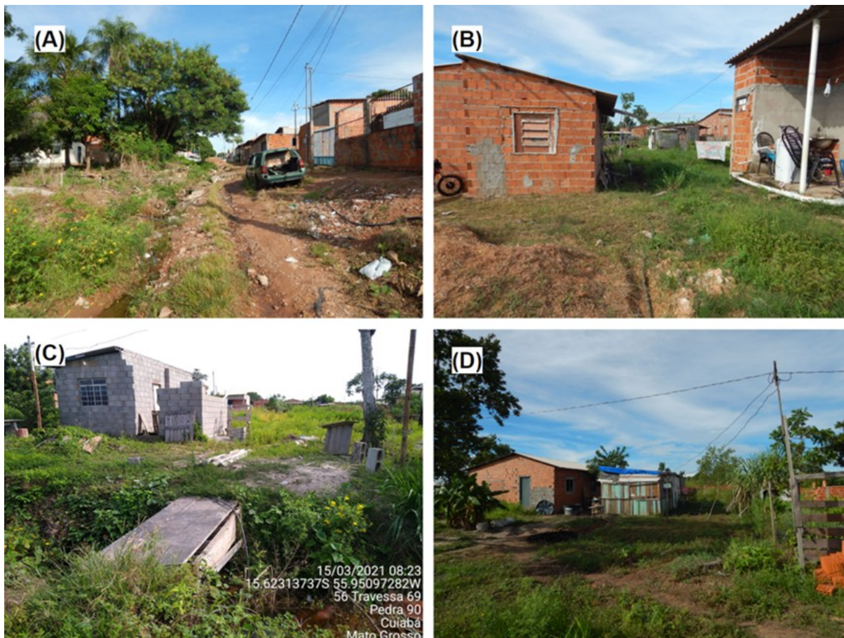
Figura 13 – Padrão construtivo das edificações. (A) e (B) Casas construídas em alvenaria sem reboco. (C) Ponte improvisada de madeira sobre o curso d'água formado pela drenagem da área de surgência, dando acesso a uma casa feita com blocos de concreto e materiais reaproveitados. (D) Casas em madeira de reaproveitamento e alvenaria sem reboco
