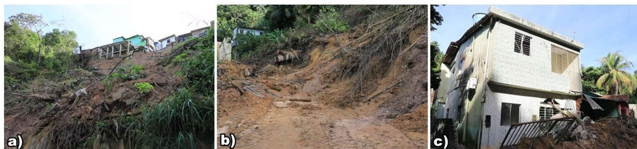
Figura 7 - Consequências dos deslizamentos de maio 2022 na rua Engenheiro Célio de Carli: a) Deslizamento ocorrido em 28/05/2022; b) Entulho obstruindo a rua; c) Danos causados nas residências localizadas na base da encosta.
