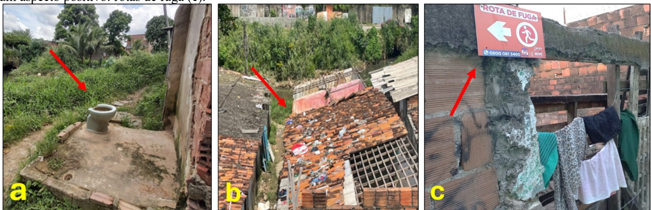
Figura 18: Exemplos de dois problemas construtivos e ambientais identificados durante a oficina: banheiros externos inadequados (a) e resíduos de lixo e detritos das inundações de 2022 nos telhados das moradias (b). Também é destacado um aspecto positivo: rotas de fuga (c).
