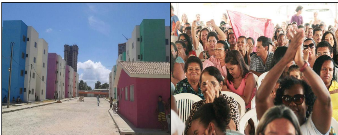
Figuras 02 e 03. Conjunto Habitacional Mércia de Albuquerque I concluído
