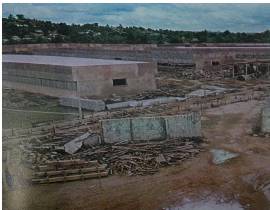
Fig. 03- Obras do Presídio do Recife 8
