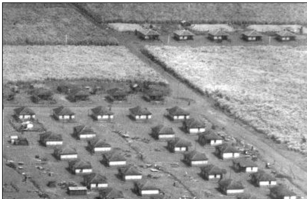
Detalhe das casas de trabalhadores da Usina Itaquerê. Nova Europa, 1939. 33
