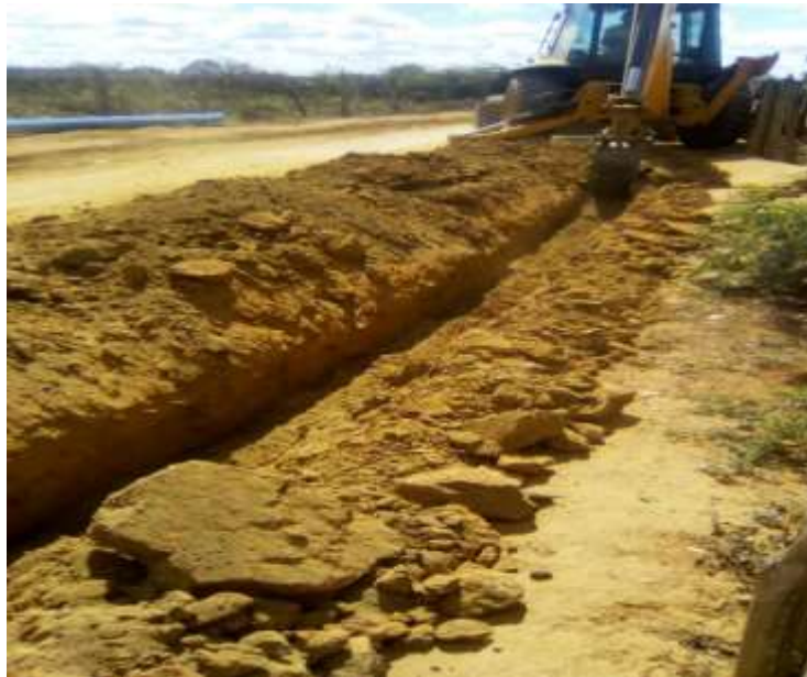
Figura 4 – Instalação de encanação de água no povoado Lagoa de Juazeiro - BA
