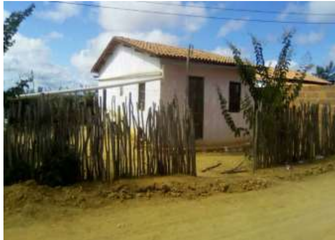
Figura 7 – Casa com cerca – Povoado Lagoa de Juazeiro
