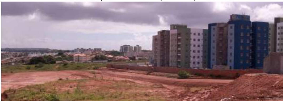
Figura 4: Vista dos condomínios construídos pelo PMCMV na zona de urbanização da Cabrita (São Cristóvão/SE) na RMA, 2018.
