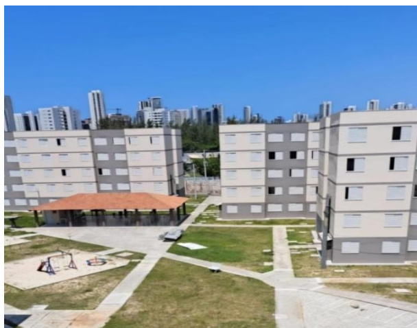
Fotografia 2. Conjunto Habitacional Encanta Moça I.
